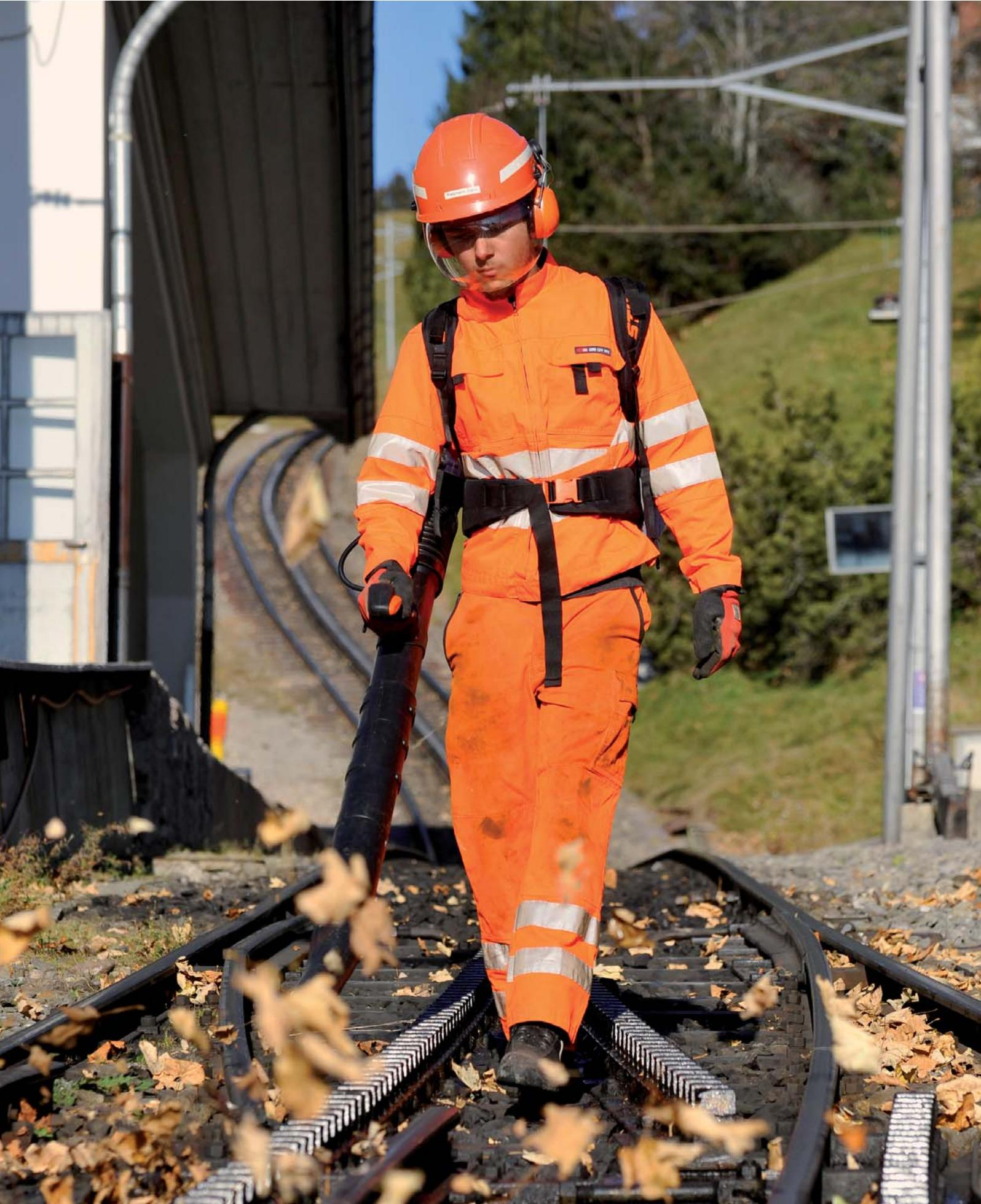
Dario Rietmann, Gleisbauer im 1. Lehrjahr, stellt durch die Reinigung der Weiche auf Rigi Kaltbad einen störungsfreien Betrieb sicher.
