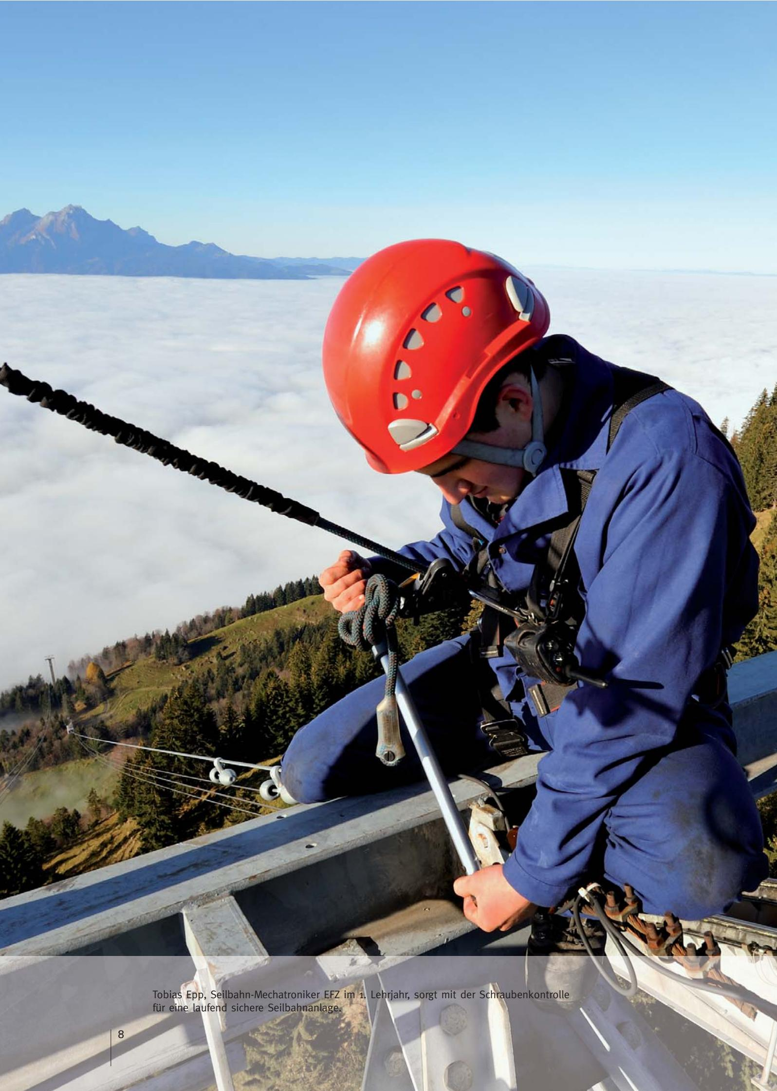
Tobias Epp, Seilbahn-Mechatroniker EFZ im 1. Lehrjahr, sorgt mit der Schraubenkontrolle für eine laufend sichere Seilbahnanlage.
