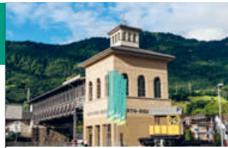
SANIERUNG/NEUBAU BAHNHOF GOLDAU
