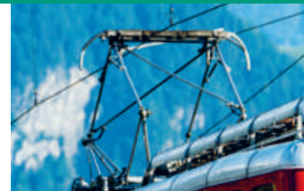
ERNEUERUNG ENERGIE- VERSORGUNG ZAHNRADBAHNEN
